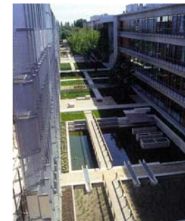
Bassins de rétention en pied d'immeuble
