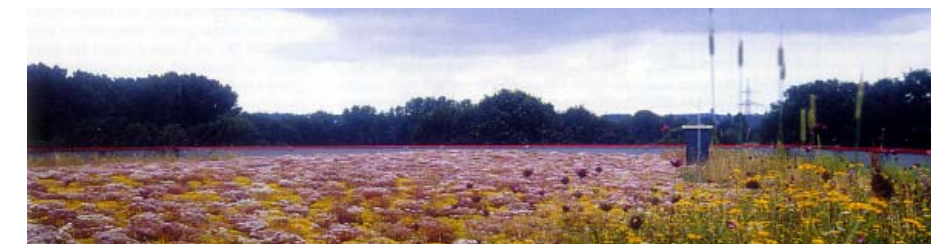
Toiture végétalisée pour retenir les eaux de pluie
