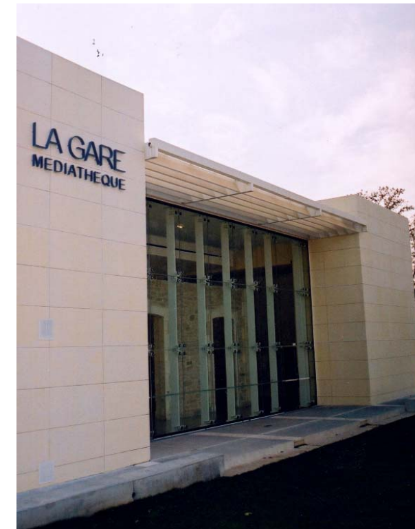
La médiathèque "la Gare" à Pignan
